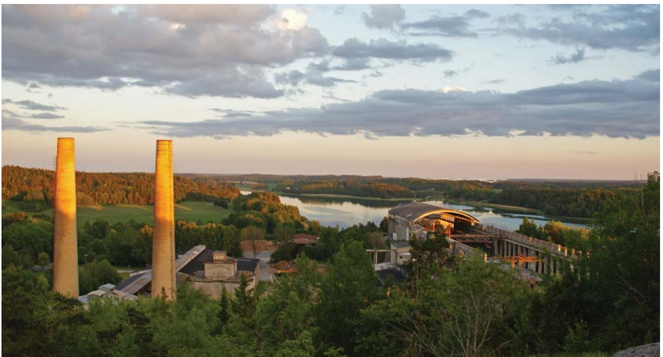
Cementfabriken. Till höger syns lagerhallen vars bågförmiga tak till stora delar har rasat de senaste åren.
